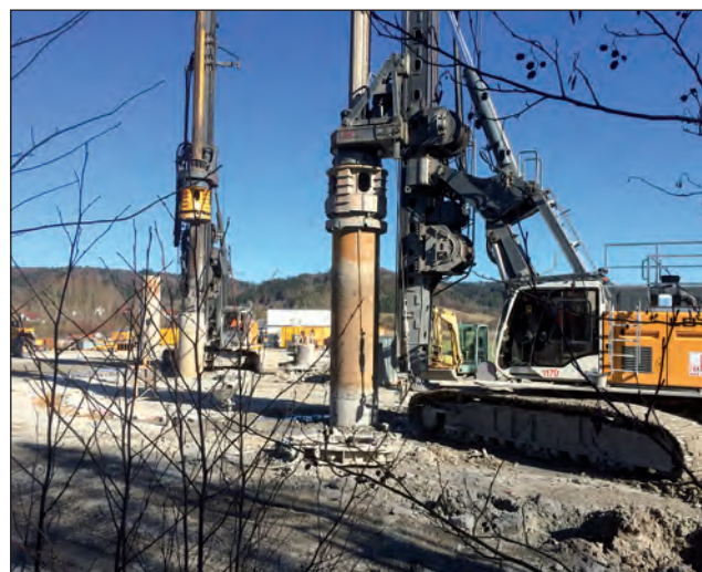
Abb. 5: Herstellen der Bohrungen für die Bohrpfehle
