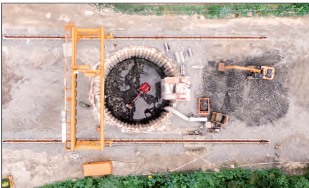
Abb. 3: Draufsicht auf die Schachtbaustelle, gut zu erkennen, die Sicherung mittels Bohrpfehlen Foto: Max Bögl Wind AG
