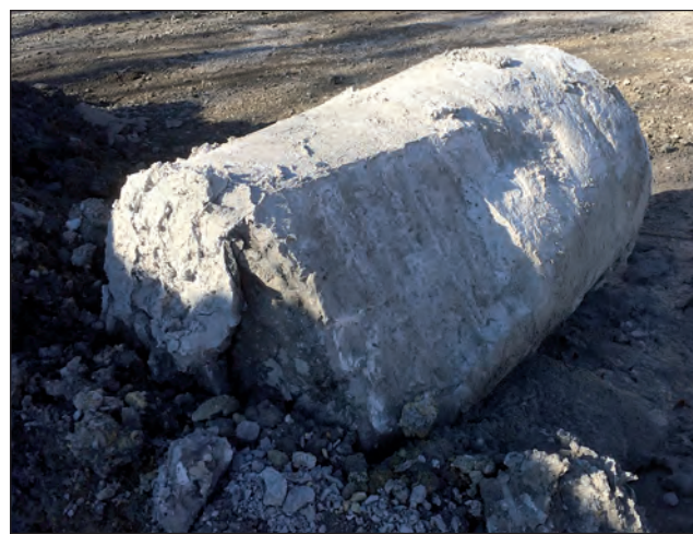
Abb. 4: Kern aus der Bohrpfehlwand
