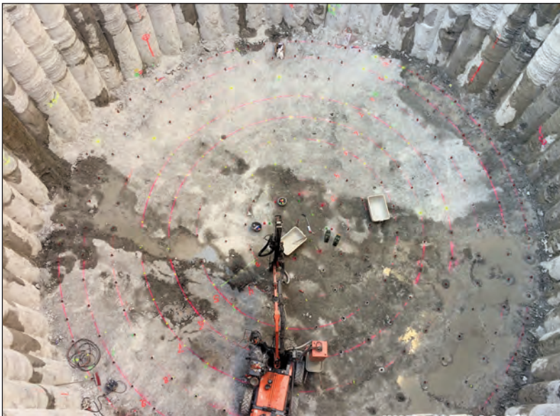
Abb. 8: Bohrarbeiten kurz vor der Fertigstellung
