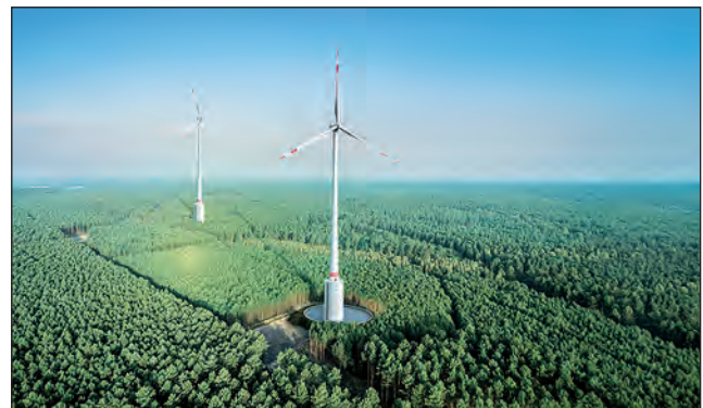
Abb. 1: Windenergieanlage mit integriertem Oberbecken
