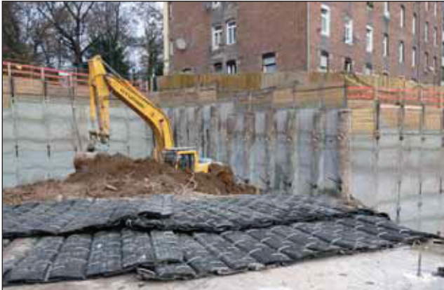
Abb. 5: Einsatz von Sprengmatten
