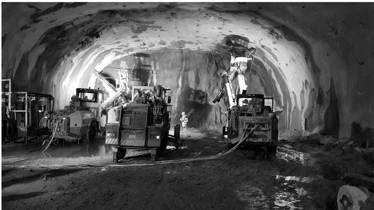
Abbildung 1: Vortriebsarbeiten in Kalotte der Kraftwerkskaverne [Kirchhofer, Engineering Service Schmücker]
